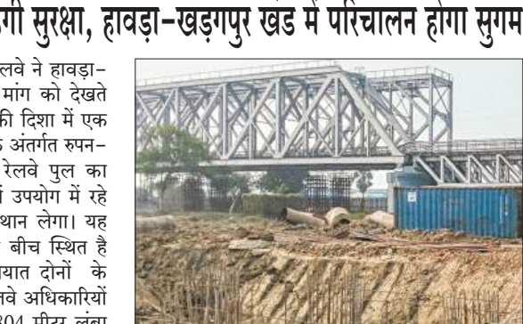
प्लेटफार्मों का निर्माण शामिल है। वर्तमान में पुराने पुल पर प्रतिबंधों के कारण डाउन मेन लाइन से मालगाड़ियों और अधिकांश मेल-एक्सप्रेस ट्रेनों का संचालन प्रभावित हो रहा है, जिससे अधिकतर डाउन ट्रेनों की मिडिल लाइन से चलाना पड़ रहा है और भीड़ की स्थिति बन रही है। रेलवे का अनुमान है कि नया पुल वर्ष 2027 के अंत तक बालू हो जाएगा और कम से कम अगले 100 वर्षों तक सेवा प्रदान करेगा। दक्षिण पूर्व रेलवे का कहना है कि इस परियोजना के पूरा होने से हावड़ा-खड़गपुर खंड में संकीर्णता दूर होगी, रेल सुरक्षा में उल्लेखनीय वृद्धि होगी और यात्रियों को अधिक तेज, सुरक्षित और सुविधाजनक यात्रा अनुभव मिलेगा।
