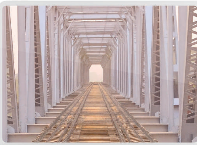
पुल निर्माण एवं फैब्रिकेशन
